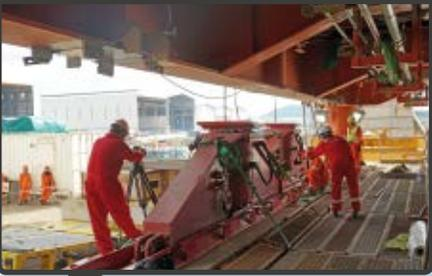
**PHOTO 2** SKIDDING 14,273 TON ITM ONTO FPU HULL
